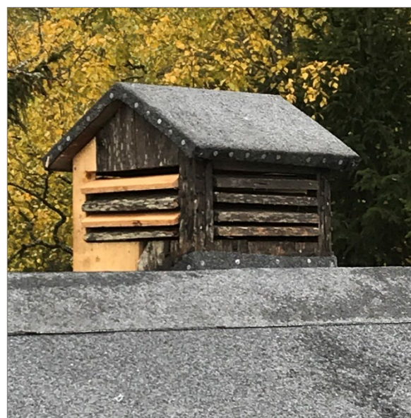
Efter restaurering av rotet har ny grundpapp och ny ytpapp lagts på och ventilationshuv på taket har genomgått en varsam renovering.
