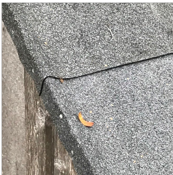
Efter restaurering av rotet har ny grundpapp och ny ytpapp lagts på och ventilationshuv på taket har genomgått en varsam renovering.
