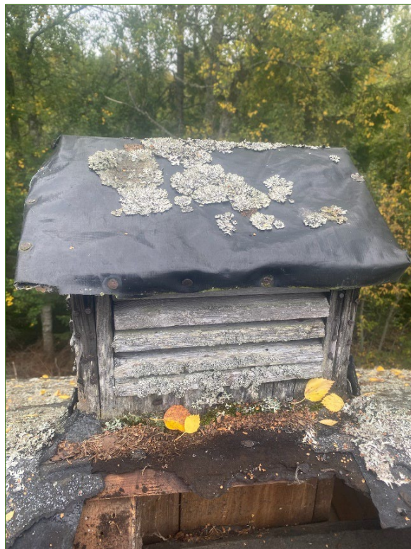
Byggnadens papptak och ventilationshuv före renoveringen.
