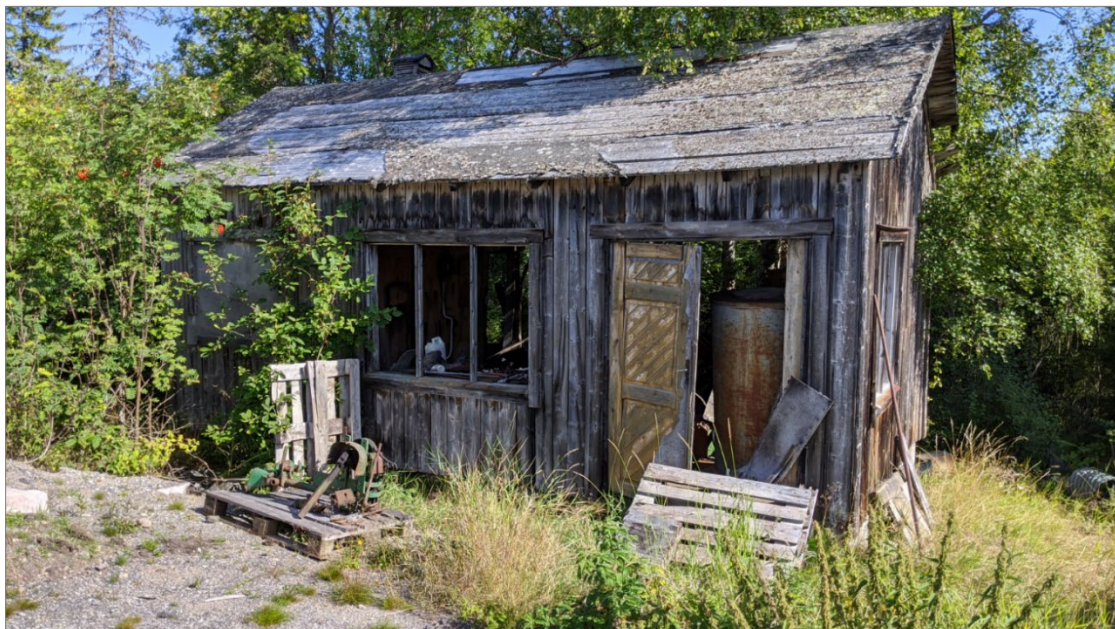
Kraftstationen fotad i augusti 2021, före renoveringen. Foto Lena Tengnér
